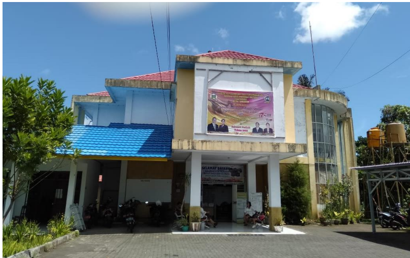
Gambar 2.1 Gedung BKPSDMD Kota Tomohon
